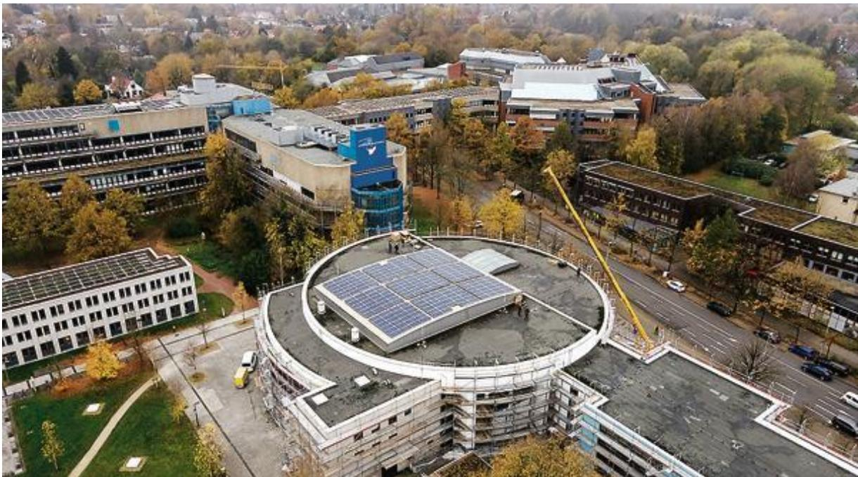
Auf dem Hörsaalzentrum wird die Photovoltaikanlage derzeit installiert. Auf anderen Gebäuden (links und links oben) erzeugen solche Anlagen schon länger Strom.
